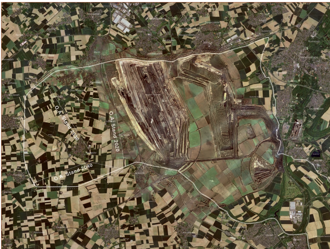
Abbildung 31 Autobahndamm A 44n (Stand Anfang 2018)
