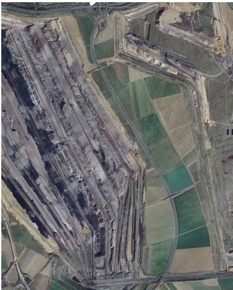
Abbildung 21 Autobahndamm A44n, Stand: Anfang 2019
