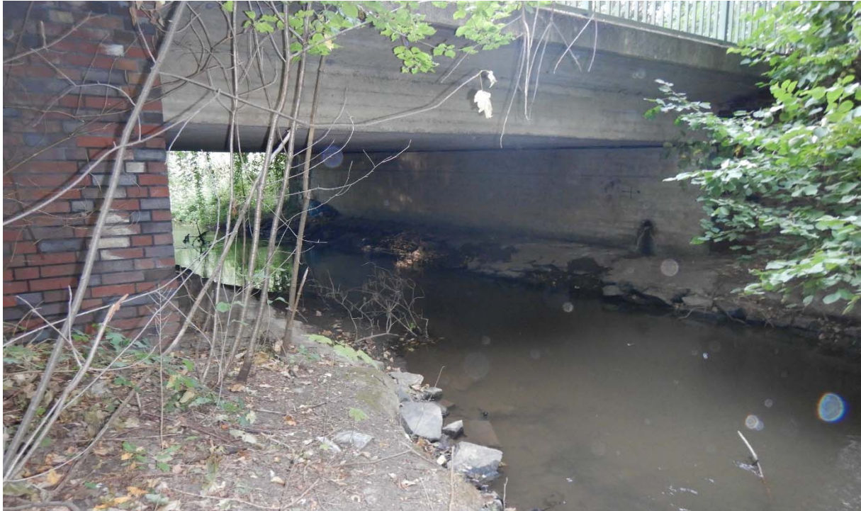
Abbildung 3 Ahe-Süd: Straßenbrücke über die Große Erft bei Ahe
