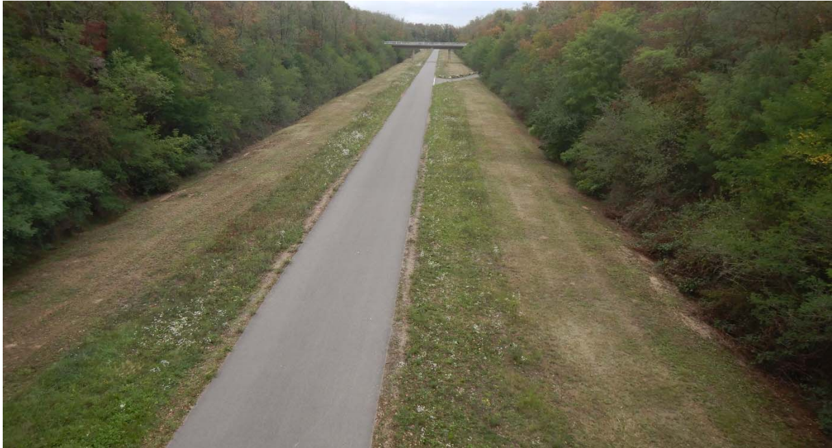
Abbildung 36 Fernbandtrasse: Blick auf die ehemalige Fernbandtrasse von der Brücke Laurentiusstraße (K30) westlich von Esch. Blickrichtung: Norden
