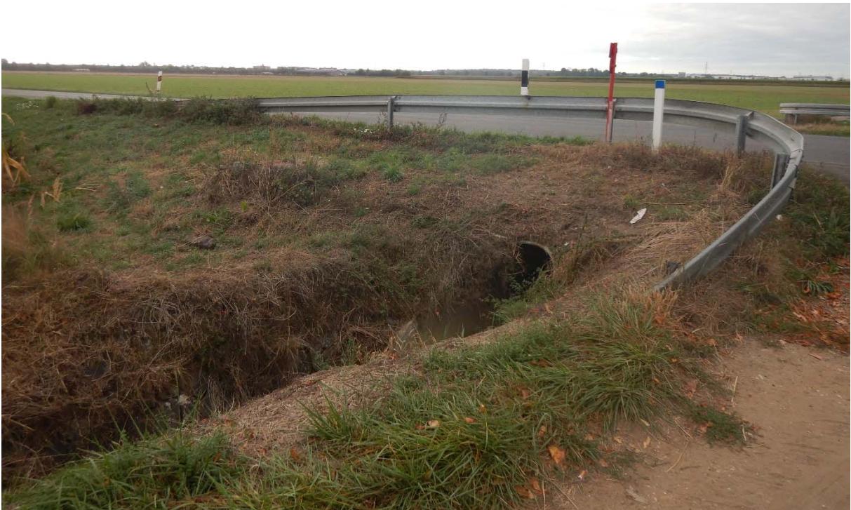
Abbildung 7 Ahe-Süd: Durchlass unter der Sindorfer Straße vor Heppendorf
