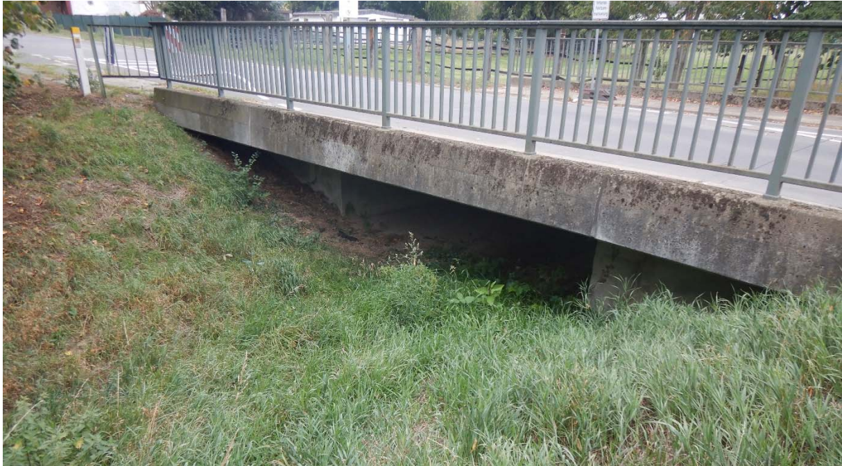
Abbildung 41 Finkelbach: Brücke Mühlenstraße nördlich von Niederermbt
