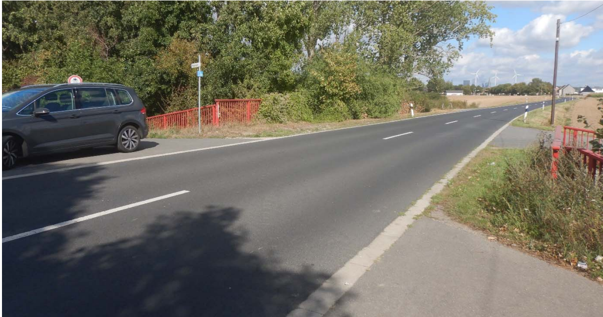
Abbildung 47 Finkelbach: Durchlass Niederembter Straße westlich von Glesch
