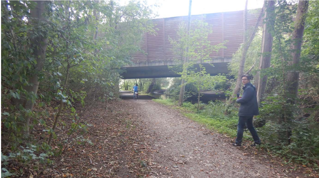
Abbildung 35 Hambachbahn: Brücke der Hambach-Bahn und Bundesstraße 477 über den Paffendorfer Mühlengraben nördlich von Zieverich
