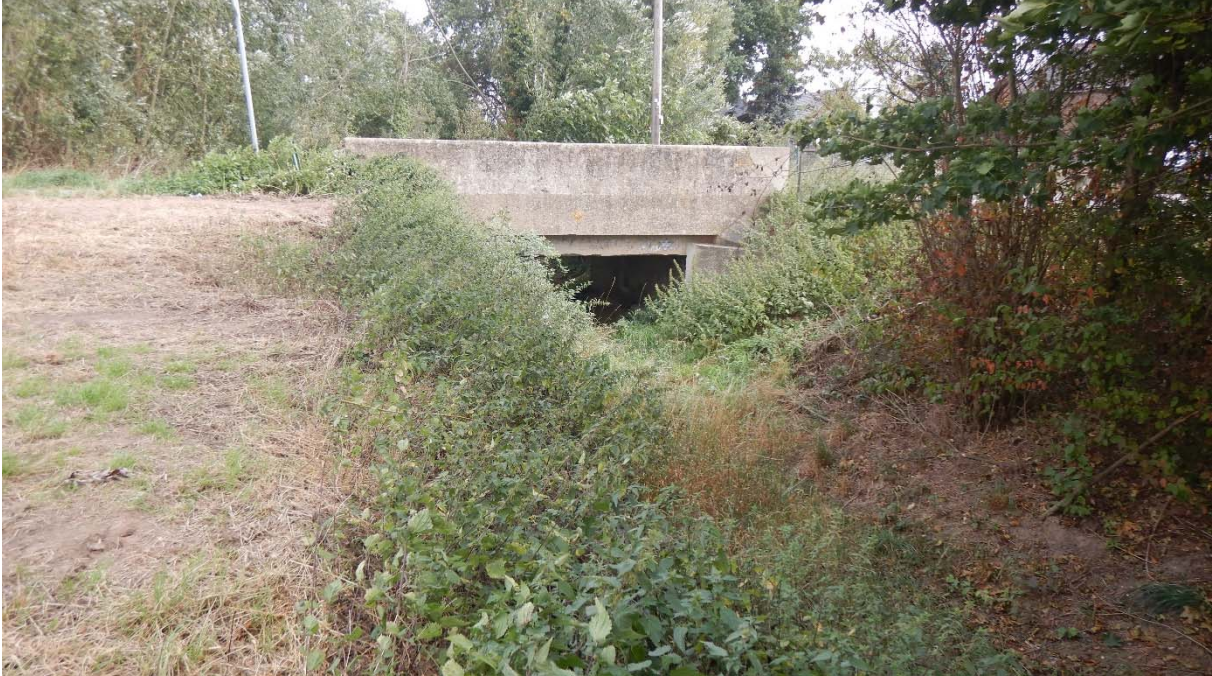
Abbildung 43 Finkelbach: Brücke Etgendorfer Weg nördlich von Niederembt
