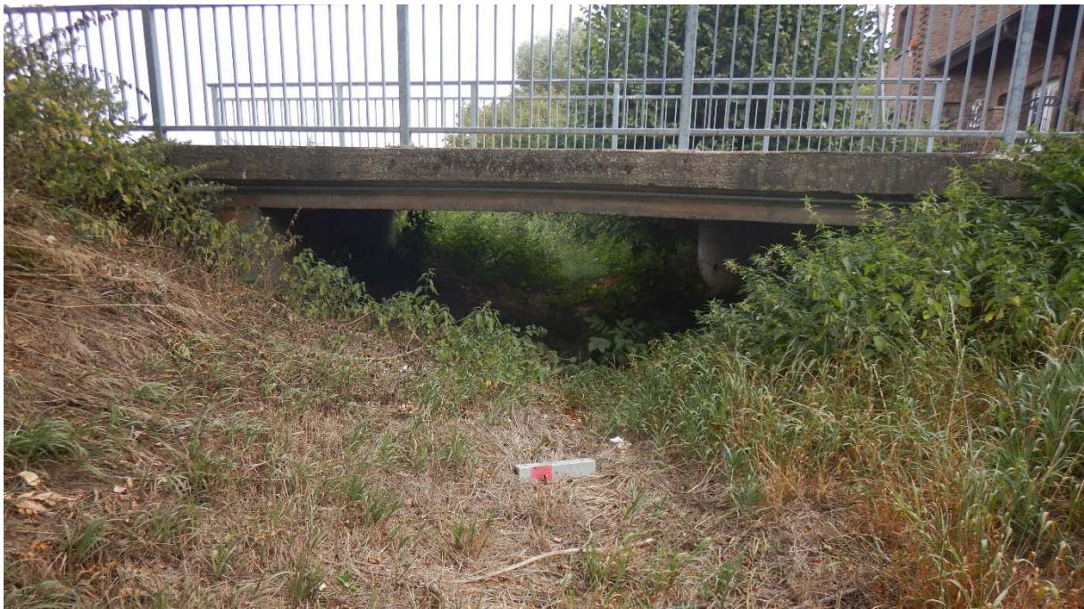
Abbildung 42 Finkelbach: Brücke Am Finkelbach nördlich von Niederermbt
