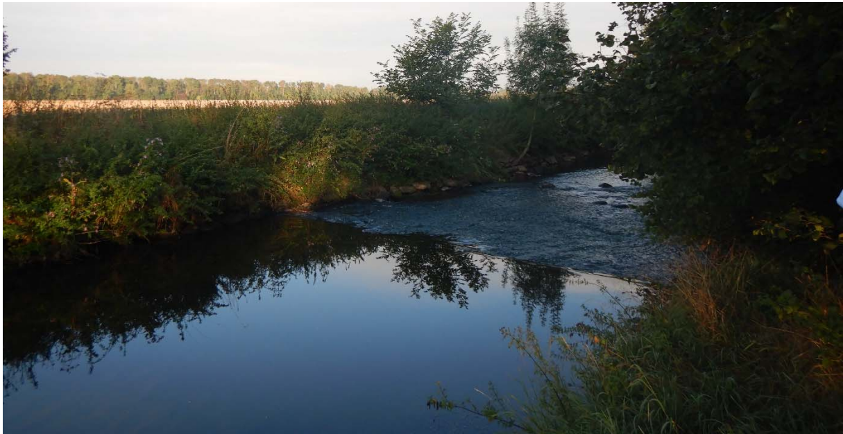
Abbildung 1 Ahe-Süd: Sohlstufe in der Erft vor Quadrath-Ichendorf
