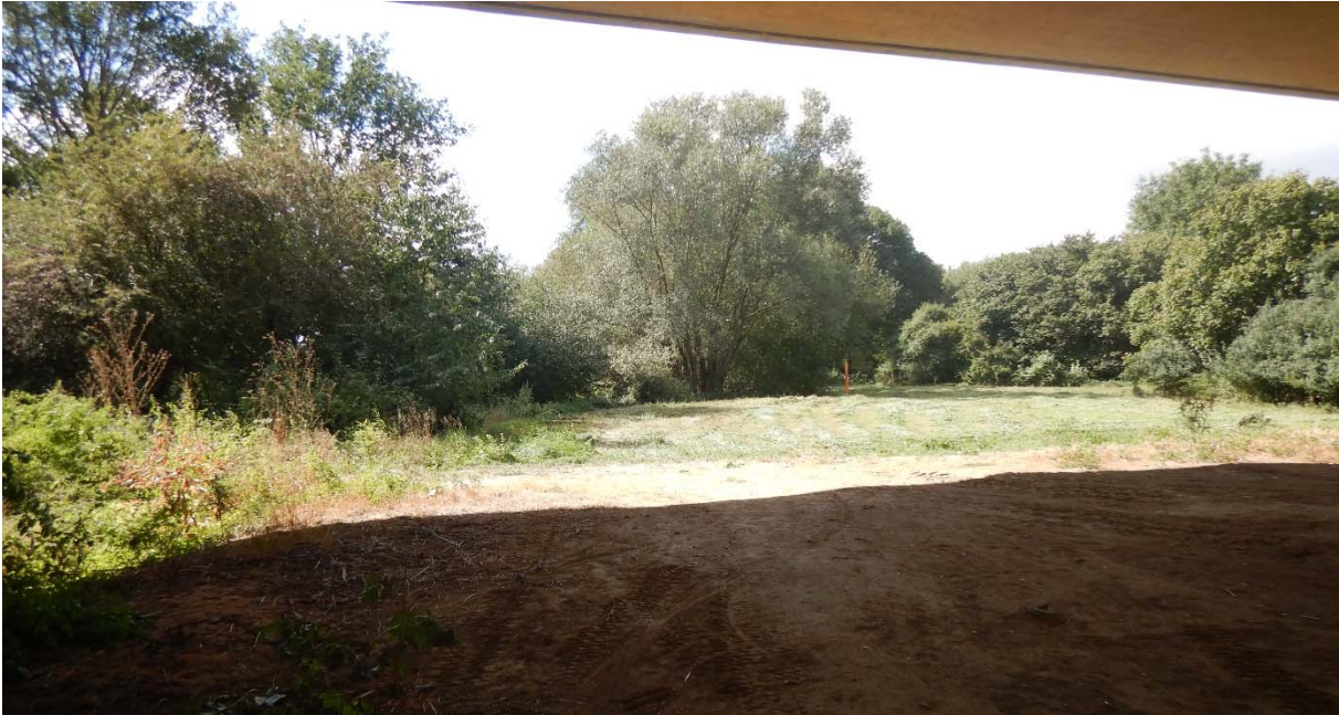
Abbildung 45 Finkelbach: Brücke der Autobahn A61. Blickrichtung: Westen
