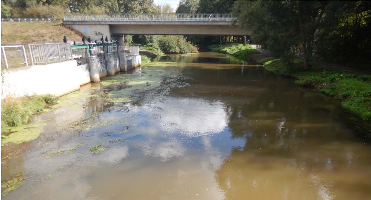
Abbildung 38 Fernbandtrasse: Hochwasserentlastungsbauwerk an der Erft. Blickrichtung: Südosten
