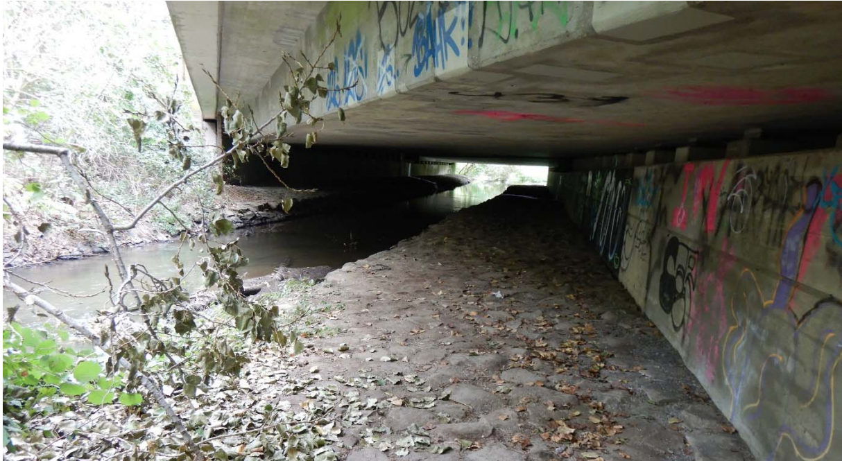
Abbildung 32 Wiebach: Autobahnbrücke über die Große Erft (A61)
