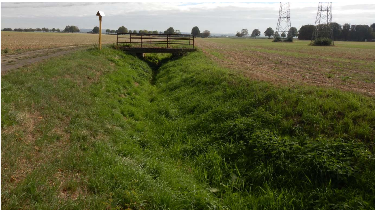
Abbildung 25 Wiebach: Ackerflächen und Hochspannungsmasten östlich der B477 und der Hambach-Bahntrasse. Blickrichtung: Osten
