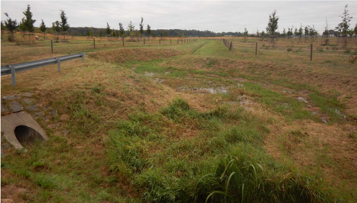
Abbildung 10 Ahe-Süd: Manheimer Fließ vor Düker unter der Hambach-Bahntrasse. Blickrichtung: Süden
