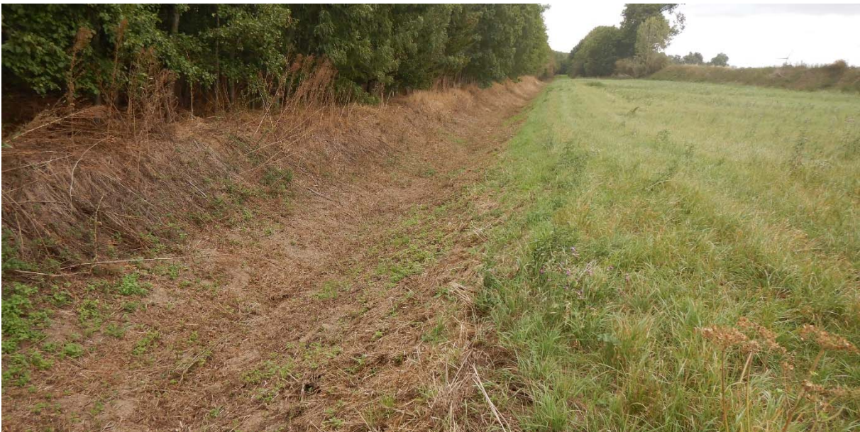
Abbildung 40 Finkelbach: Der Finkelbach am Durchlass Mühlenstraße nördlich von Niederrembt. Blickrichtung: Westen
