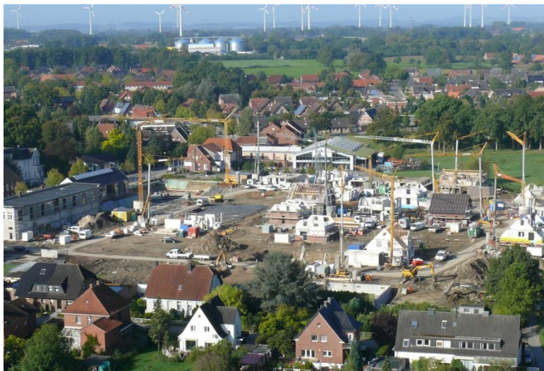
Neubau in Umsetzung
