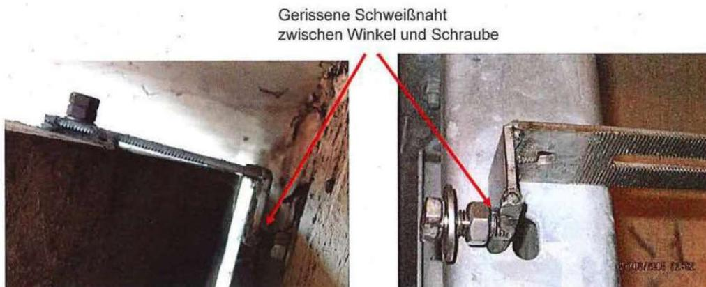
Abb. 1: Winkelkonstruktion als improvisierte Befestigung
