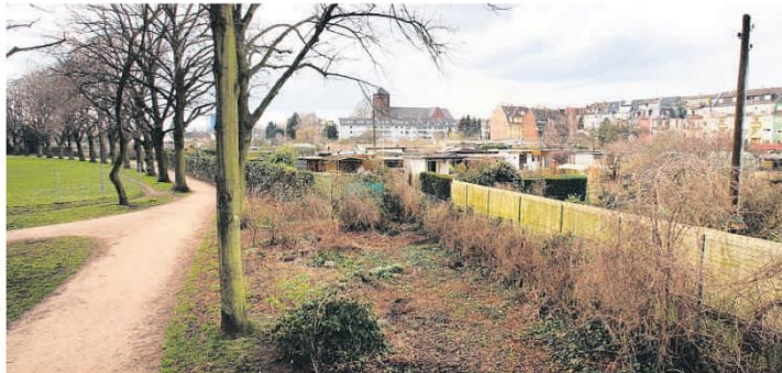
Viel Platz für neue Wohnungen in bester Lage wäre zwischen Innerer Kanalstraße und dem Nippser Sechzigviertel. Doch dafür müssten einige Schrebergärten und Freiflächen aufgegeben werden. Die Rasenflächen (im Bild links) würden bleiben. Fotos: Martina Geoyert
