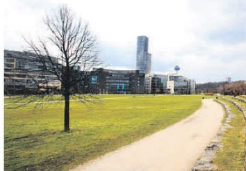
Zumindest ein Teil der Grünfläche im Mediapark in der Innenstadt könnte für Neubauten geopfert werden.
